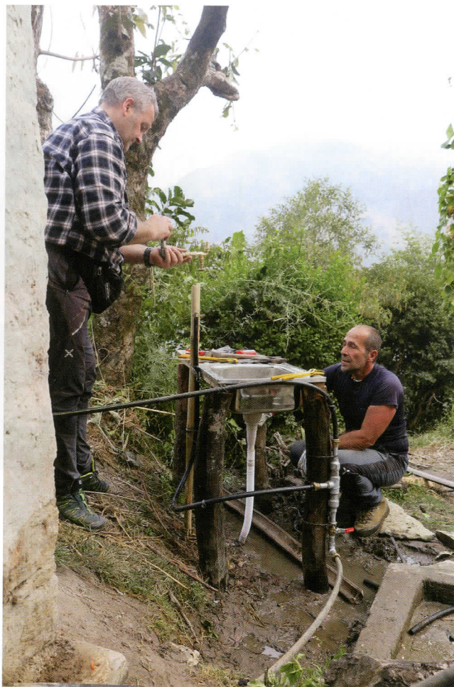
Marino e Claudio al lavoro per installare un lavandino
